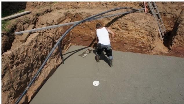
Wenn die Außentemperatur sehr warm sein sollte, spitzen Sie gelegentlich etwas Wasser mit dem Gartenschlauch auf die Betonoberfläche. Somit verhindern Sie ein zu schnelles Austrocknen, was zu Rissen führen kann.
