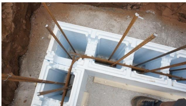
Jeder angrenzende Baustahl muss mit einer Länge, die dem 50-fachen des Querschnitts des eingesetzten Baustahls entspricht, überlappen und min. 2-mal verflochten (gebunden) sein.
