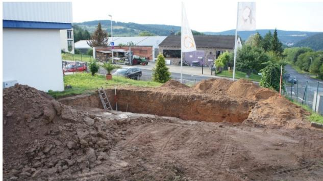
Nach dem Aushub der Baugrube, sollte eine Kiesschicht aufgeschüttet und anschließend verdichtet werden. Diese Schicht wird als kapillarbrechende Schicht, Rollierung oder auch Frostschutzschicht bezeichnet. Grund für den Einbau einer kapillarbrechenden Schicht ist die Notwendigkeit, die Bodenplatte vor aufsteigender Feuchtigkeit zu schützen.
